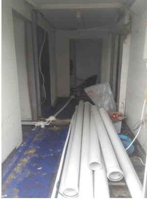
Kalıcı Konutlar Müfreze; Su Tesisatı Döşeme İşi
