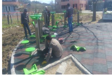
Çakırlar Mahallesi Fitness Aleti Montajı
