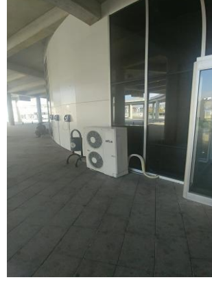
Terminal Klima Montajı
