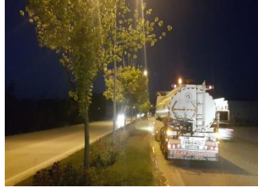
Bağlantı Yolu Sulama Çalışması
