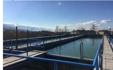
İçme Suyu Arıtma Tesisi Durultucu Havuzlar
