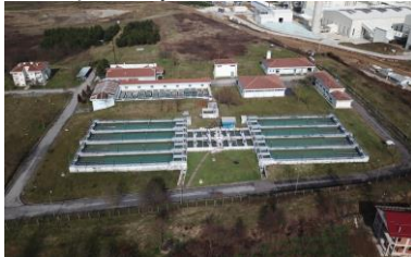
İçme Suyu Arıtma Tesisi
