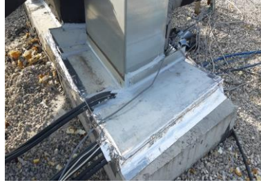
Terminal Çatı Baca Dibi Lokal Poliüretan Uygulaması
